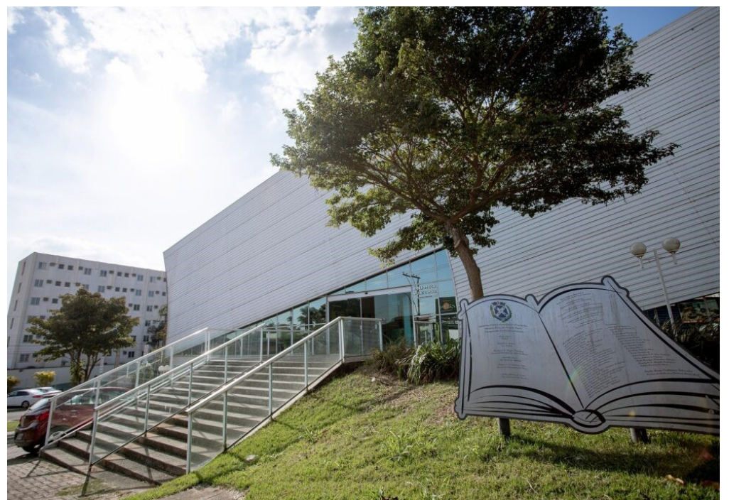
A bela Biblioteca Municipal Ricardo Ferraz de Arruda Pinto: projeto do arquiteto João Chaddad, ex-presidente do IPPLAP (Instituto de Pesquisas e Planejamento de Piracicaba) - Foto: Site Prefeitura de Piracicaba
