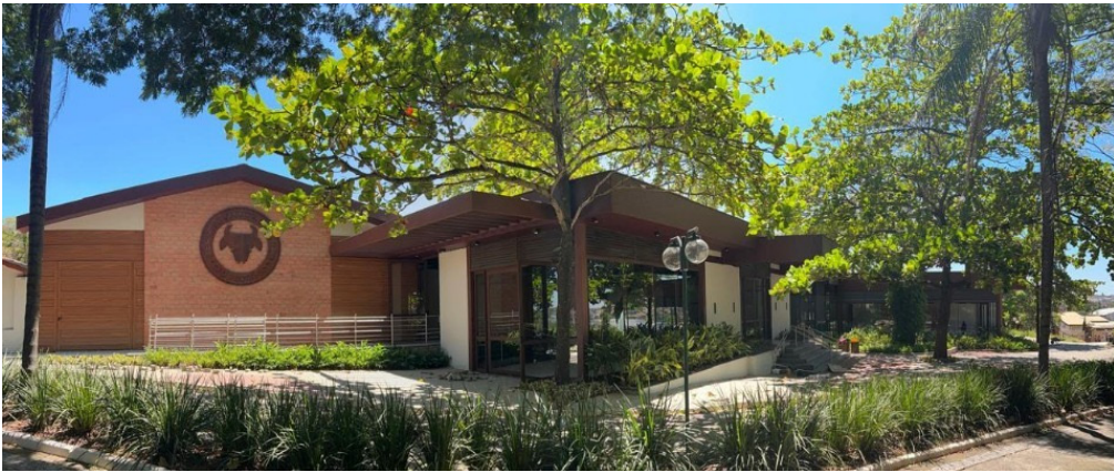
Fachada do Hotel Fazenda São João, em São Pedro
