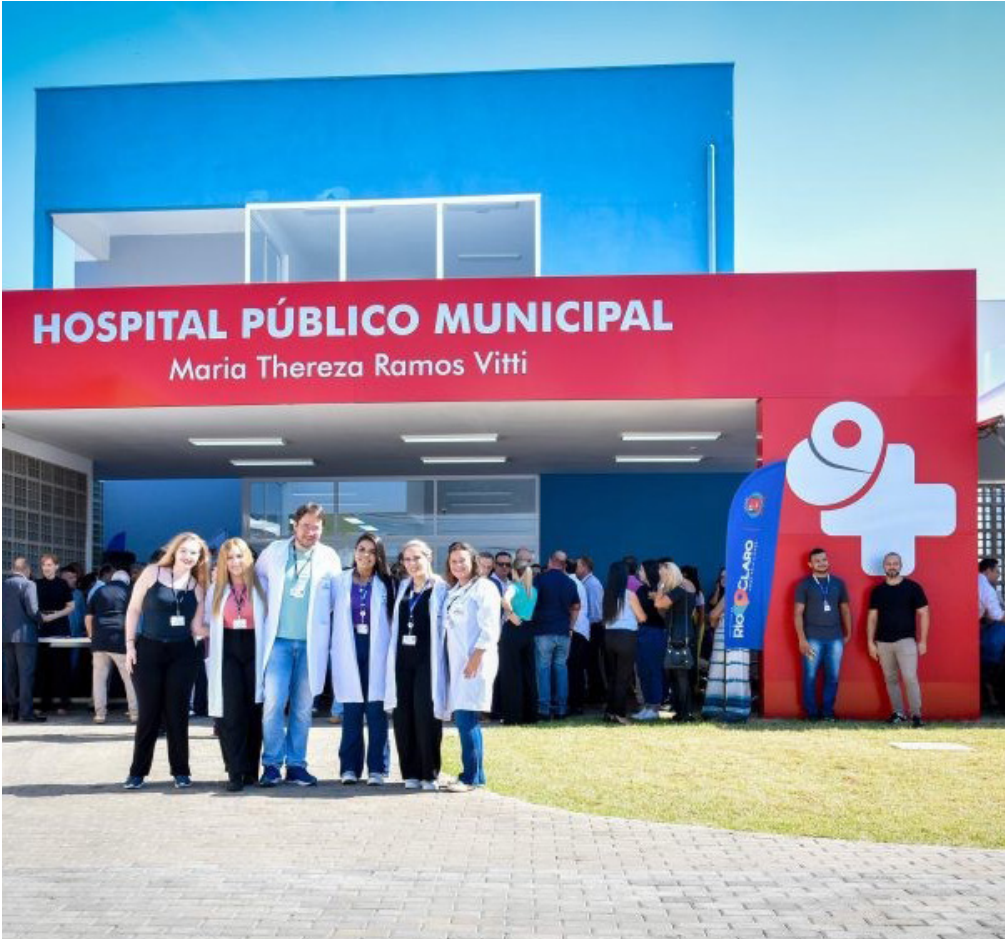
Fachada do hospital inaugurado em Rio Claro: marco para a saúde pública da cidade - Foto: Prefeitura de Rio Claro
